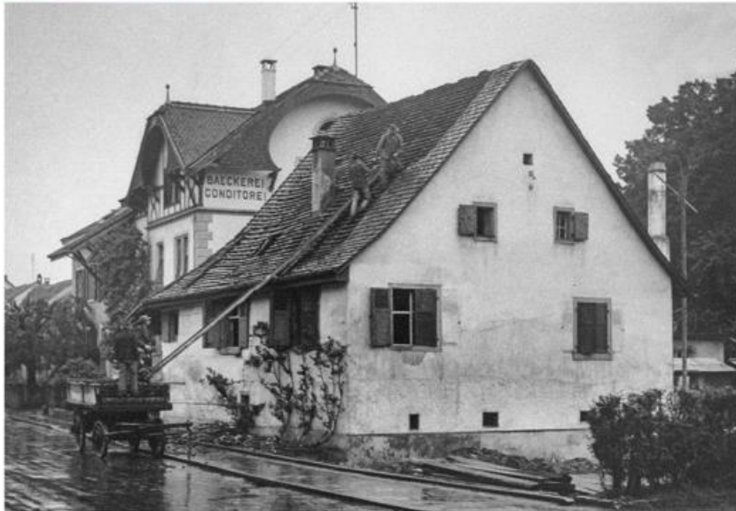
Abbruch bestehendes Gebäude für Neubau «Mibo» (Milchzentrale Bottmingen).
